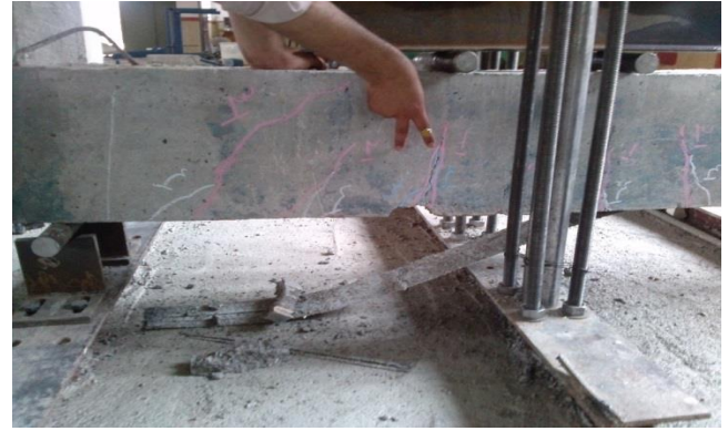
شکل ۷. جدشدگی ورق تقویت تیر B2 Fig. 7. FRP De-bonding at Sample B2
