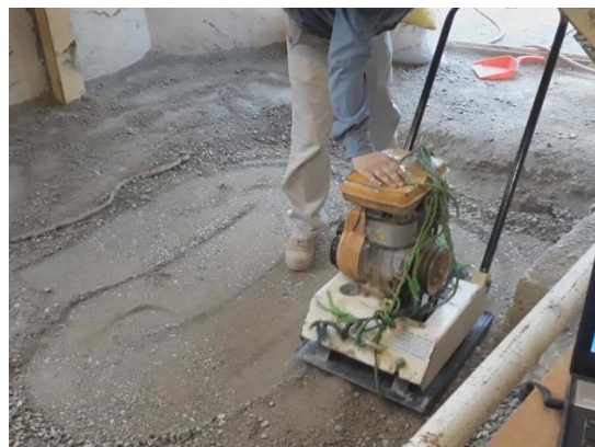
شکل ۵. تصویری از کوبیدن بستر با کمپکتور بنزینی
