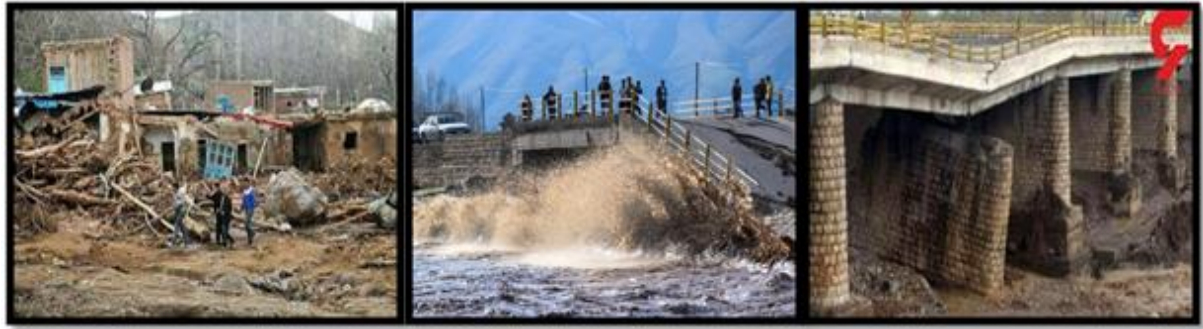
شکل ۱. نمونه‌ای از پل‌ها و ساختمان‌های تخریب شده در اثر سیل شمال غرب ایران در سال ۱۳۹۶
