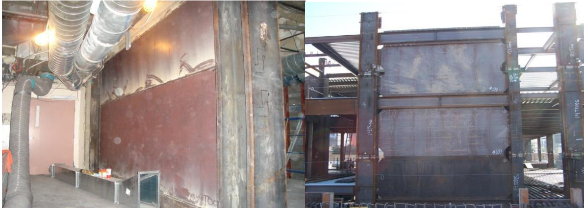
شکل ۱. نمونه اجرایی دیوار برشی فولادی
