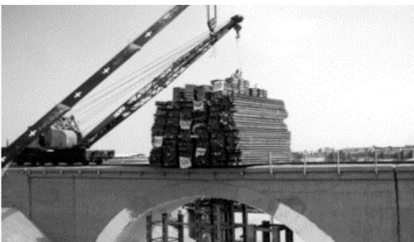
شکل (۲): بارگذاری استاتیکی پل کیلومتر ۲۳
