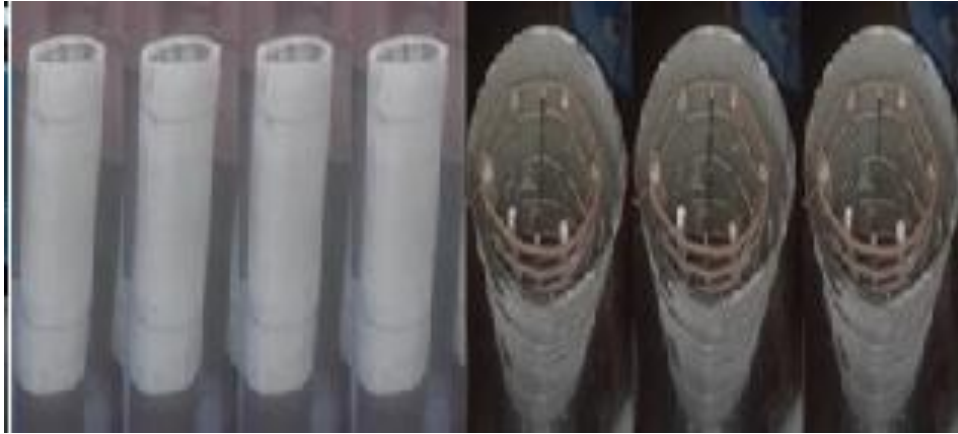
شکل ۳. نحوه قرارگیری قفسه میلگردها درون غلاف و قالب ها
