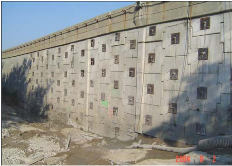
شکل ۱. سیستم ترکیبی موازی متشکل از تسمه فلزی و المان‌های میخ بدون اتصال به یکدیگر [۲]
