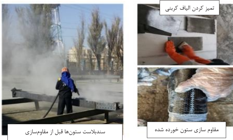
شکل ۶. انجام سندبلاست، تمیز کردن الیاف کربنی و مقاوم‌سازی ستون‌ها
