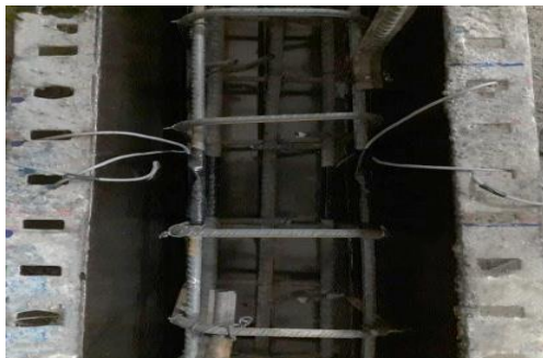
شکل ۴. نحوه بستن شبکه آرماتور و قالب فلزی.
