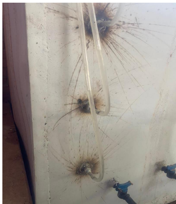
شکل ۱۰. جایگذاری پیزومترها در سیستم فیلتر زهکش
