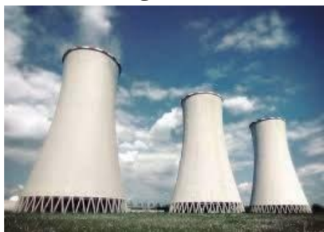
ب- برج خنک کننده b. Cooling tower
