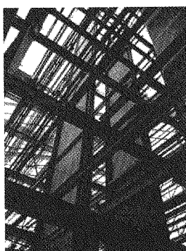
شکل (۴): ساختمان ۶ طبقه در حال ساخت در کبک کانادا[۱۵]
