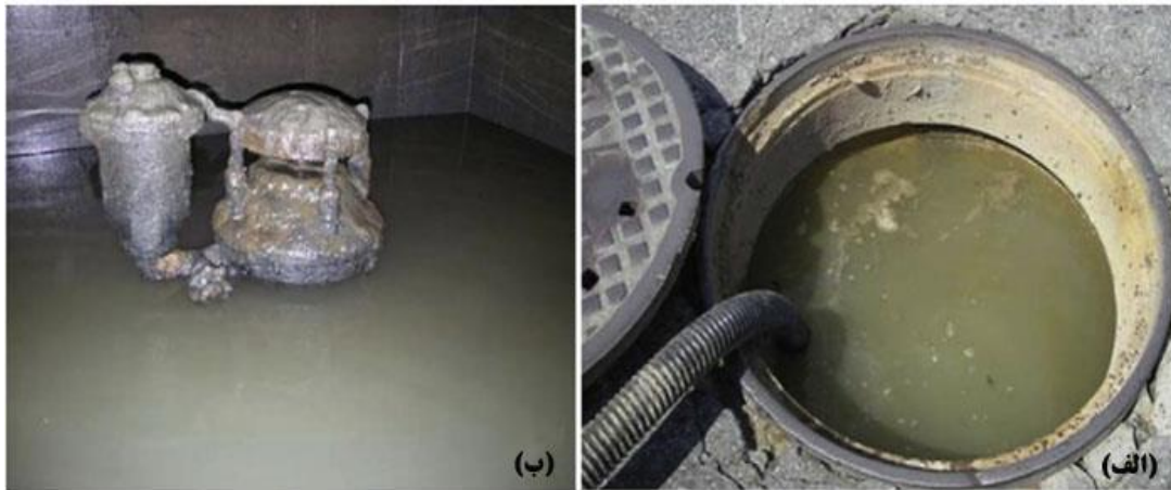
شکل ۱. الف) شیر هوای مستغرق. ب) شیر هوای نیمه مستغرق Fig. 1. a. completely submerged air valve. b. Semi-submerged air valve.
