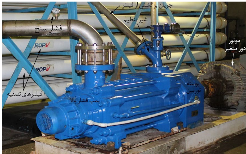
شکل ۱۵: نصب پمپ توربین دار در سایت آب شیرین کن و انجام تست‌های عملکردی
