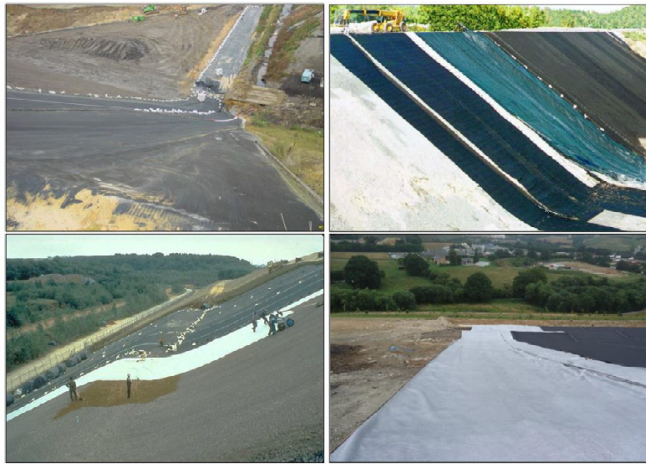
شکل ۲. اجرای سیستم پوشش و عایق در شیروانی‌های خاکی [۵] Fig. 2. Implementation landfill covers on slopes
