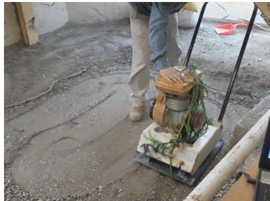
شکل ۵. تصویری از کوبیدن بستر با کمپکتور بنزینی
