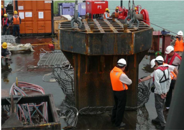
شکل ۱۱: کوبه مورد استفاده در عملیات تراکم دینامیکی فراساحلی با طراحی ویژه [۱]
