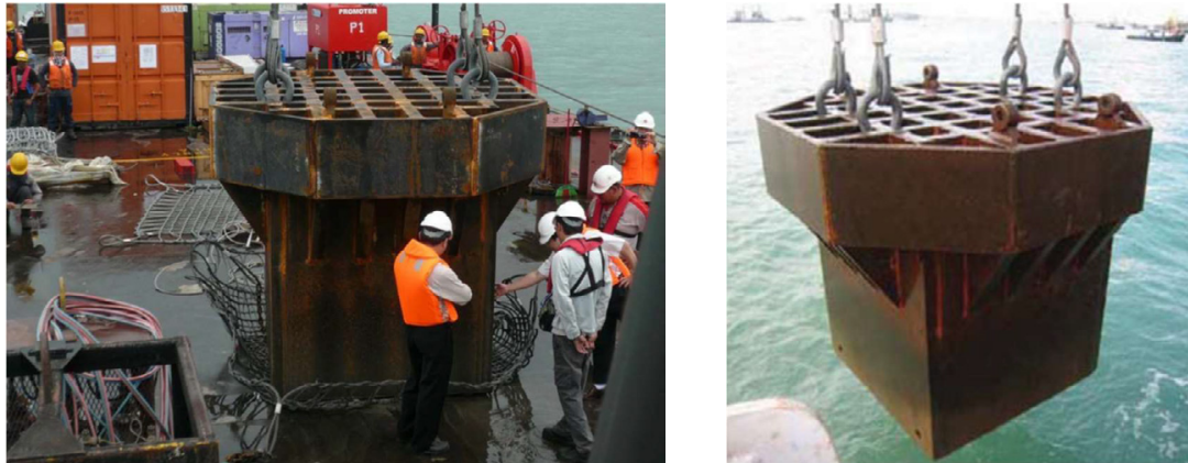
شکل ۱۱: کوبه مورد استفاده در عملیات تراکم دینامیکی فراساحلی با طراحی ویژه [۱]
