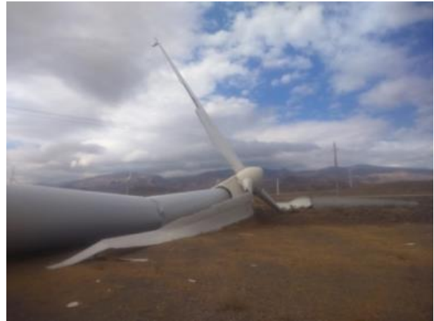
شکل ۱: سقوط برج توربین بادی نیروگاه منجیل به واسطه شل‌شدگی پیچ‌ها
