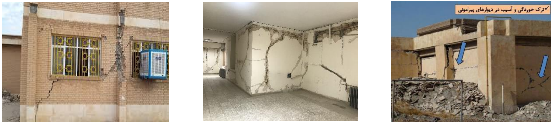
شکل ۱. خسارت داخل صفحه میان‌قاب‌های مصالح بنایی در زلزله ۲۱ آبان ماه کرمانشاه ۱۳۹۶ [۱] Fig. 1. In-plane damage of infill masonry, earthquake Kermanshah 2 Nov. 2017.
