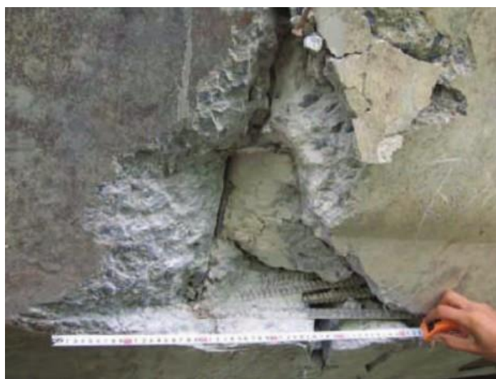
شکل ۴. آسیب های رخ داده در پل یونگ شامل ترک در (a) بخش میانی عرشه و (b) آسیب در پایه های بتنی پل [۲۸]
