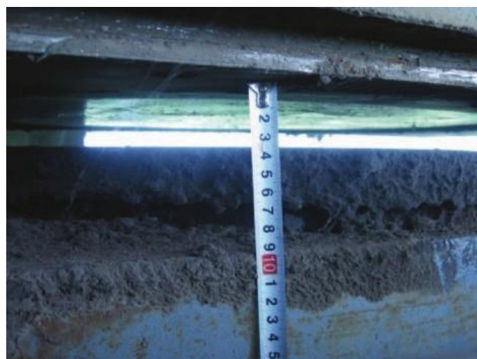
شکل ۴. آسیب های رخ داده در پل یونگ شامل ترک در (a) بخش میانی عرشه و (b) آسیب در پایه های بتنی پل [۲۸]
