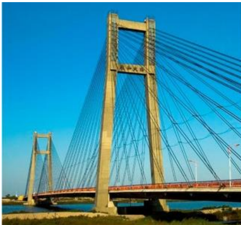
شکل ۲. نمایی از پل کابلی یونگ [۳۶]
