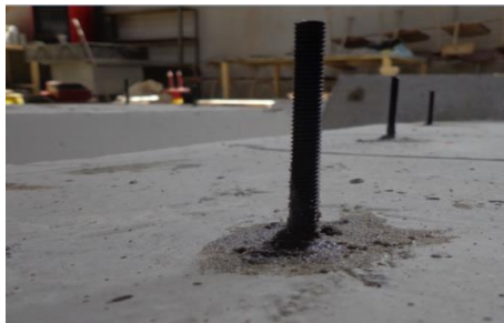
شکل ۱۳. کاشت مهارهای مکانیکی Fig. 13. Anchorage procedure
