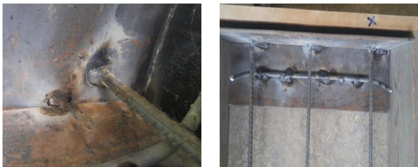
شکل ۹. ورق‌های تکیه‌گاهی دال‌ها Fig. 9. Slab's support sheets
