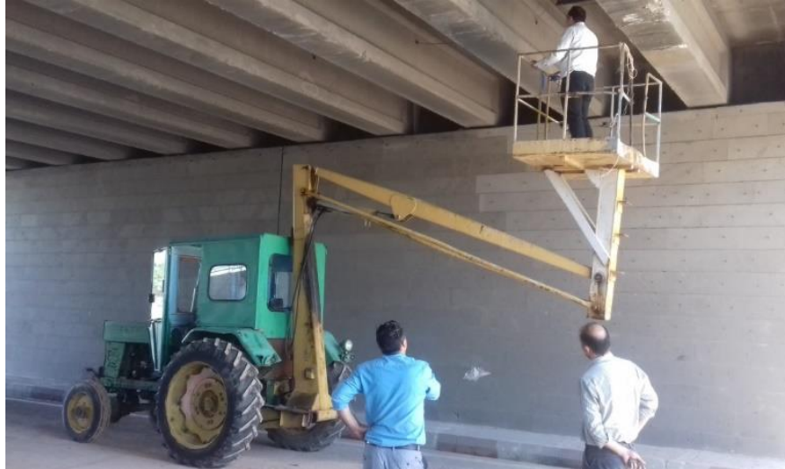
شکل ۱۲. اندازه‌گیری ابعاد شاه تیرهای بتنی
