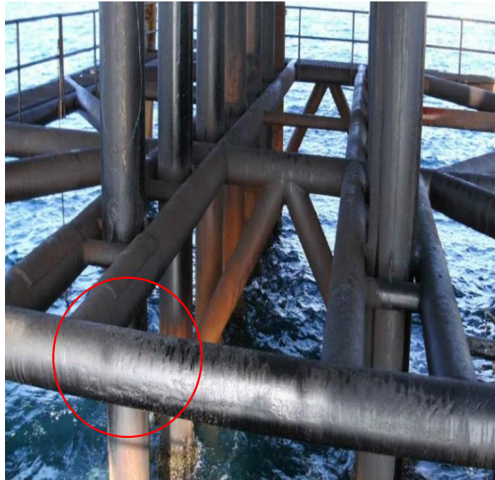
شکل ۱. نمونه اتصال T شکل به کار رفته در سکوی نفتی حفاری فراساحلی نصر ۶ واقع در میدان نفتی سیری.
