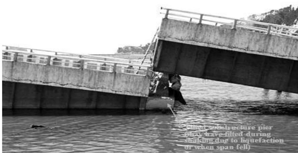
شکل ۱. سقوط و جابه‌جایی دهانه‌های پل Raqui ۲ در اثر روانگرایی [۱]
