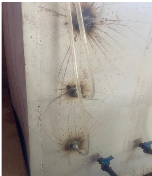
شکل ۱۰. جایگذاری پیزومترها در سیستم فیلتر زهکش
