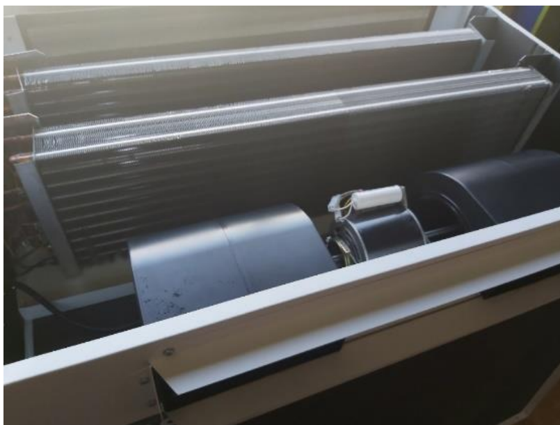
شکل ۳. اجزاء داخلی یونیت داخلی
