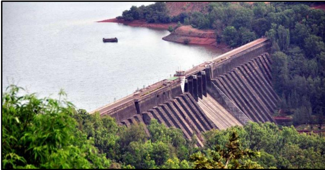
شکل ۴. نمایی از سد بتنی وزنی کوینا واقع در کشور هند
