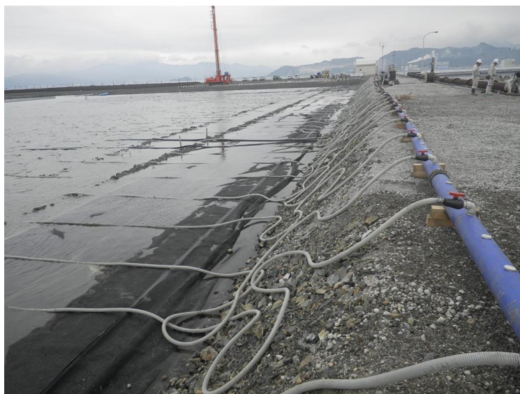
شکل ۱. پیش بارگذاری به وسیله بار سربار و بار خلاء [۱۵]
